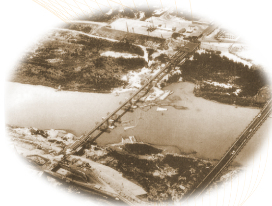
Construcción del Puente Internacional 1 (1955)
